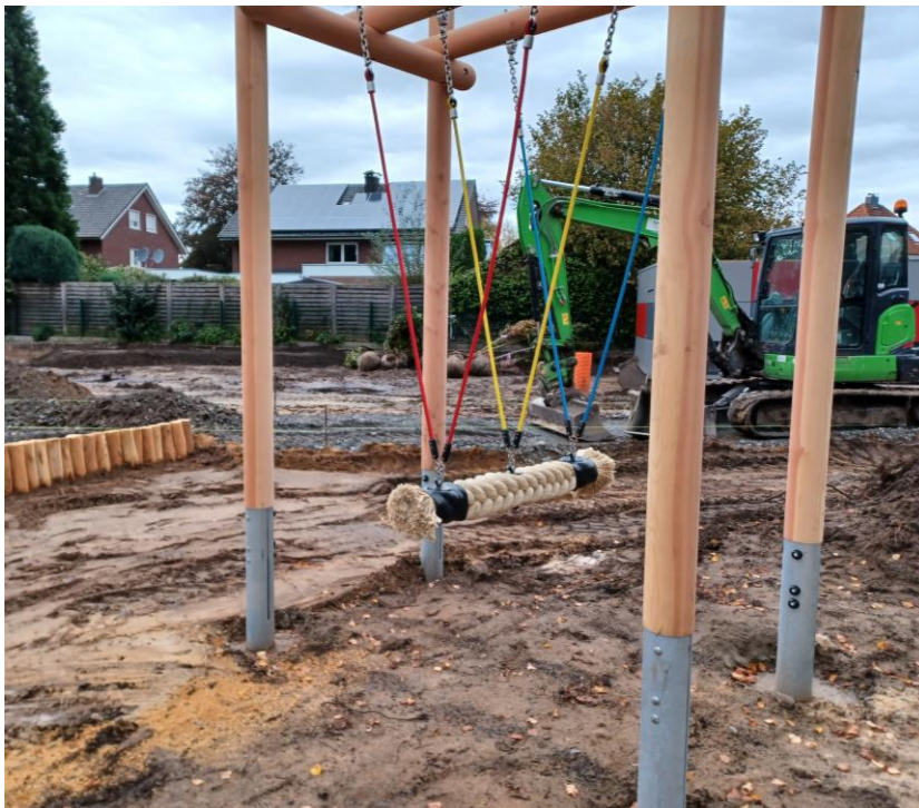
Hersteller: Sauerland Spielgeräte GmbH, Baustellenfoto
